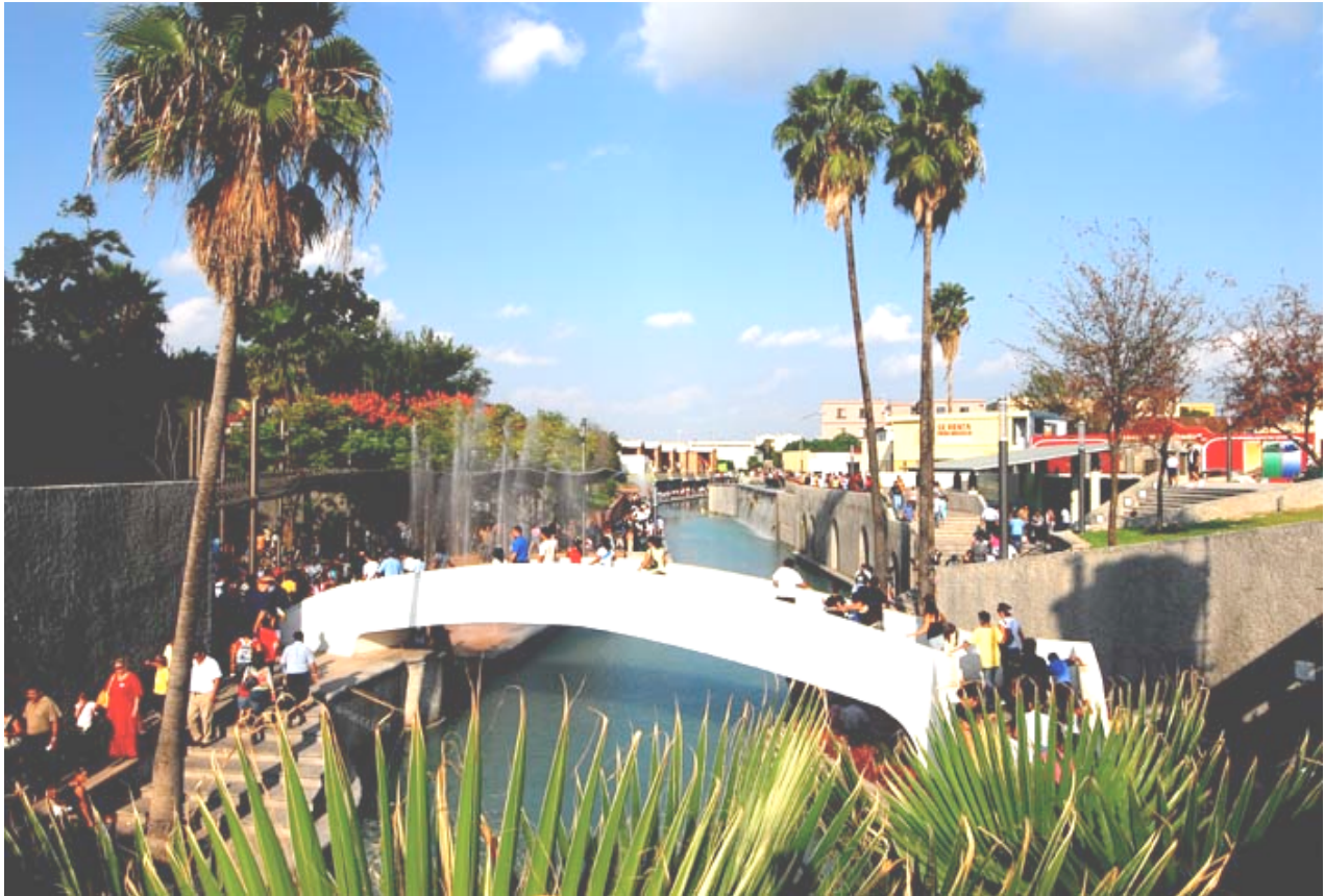
Monterrey: Reurbanización del Canal de Santa Lucía (Foto: Secretaría de Obras Públicas, Monterrey)
