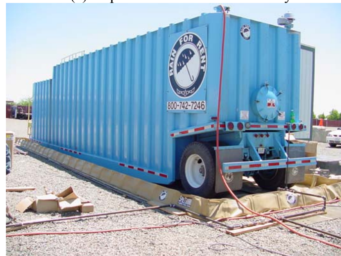
(d) 21,000-gal Wastewater Holding Tank
